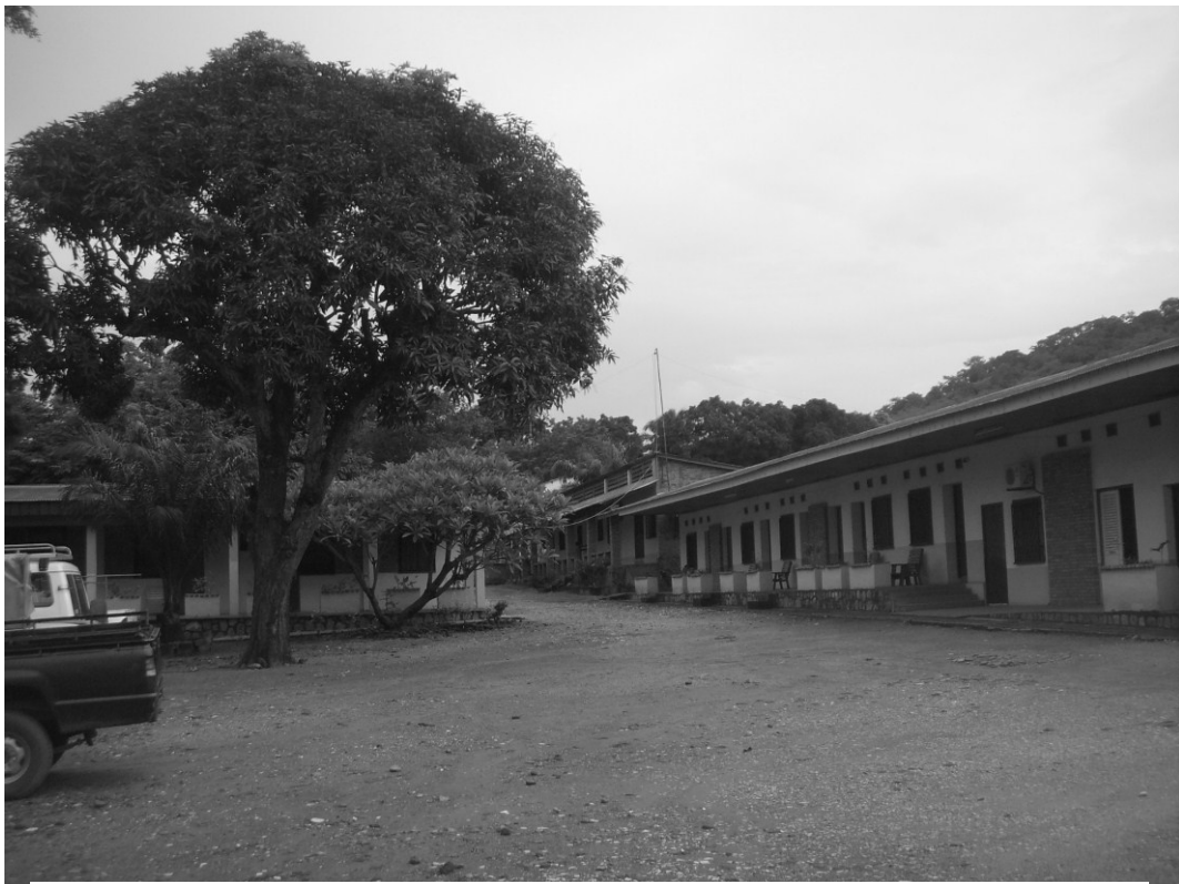
Le centre d'accueil comprend 4 bâtiments construits autour d'une grande cour. On voit à droite un bâtiment de chambres et à gauche l'aile administrative.
